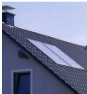
Indach Besonders elegante Optik und eingesparte Dacheindeckung plus höhere Leistung
