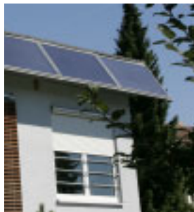
Vordach Für gleichzeitigen Sonnenschutz und solare Energiegewinnung. Interessantes Gestaltungselement
