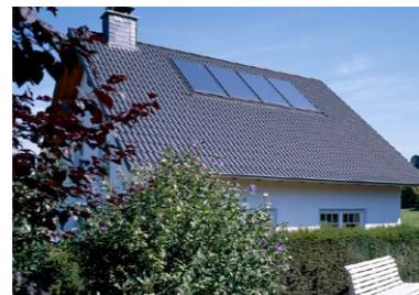
Eengezinswoning met thermische zonne-energie-installatie voor bijkomende verwarmingsondersteuning
