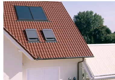
Eengezinswoning met thermische zonne-energie-installatie voor de waterverwarming
