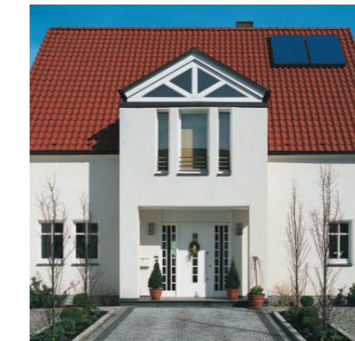
Eengezinswoning met een Schüco Compact-installatie voor waterverwarming
